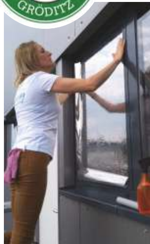
Ines Krauskopf – Fingerspitzengefühl braucht es bei der Montage von Sonnenschutzfolien ...
