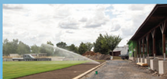
Stadion am Eichenhain: Bauarbeiten auf der Zielgeraden
